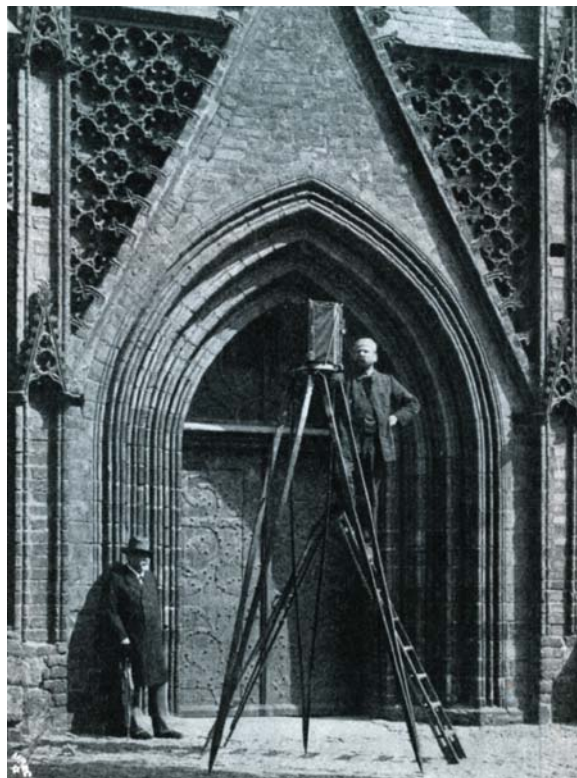
Figure 12 Photogrammetry campaign, reproduced in: A. Nothnagel, 'Meßbildverfahren und Denkmäler-Archive', in: Deutsche Bauzeitung , vol. 40, 10 November 1906, page 615.
